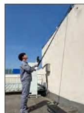
ispezione del tetto
